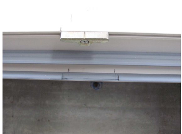
Bild 9 Druckausgleich Blendrahmen
