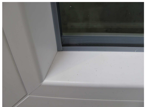
Bild 5 Verglasungsdichtung innen
