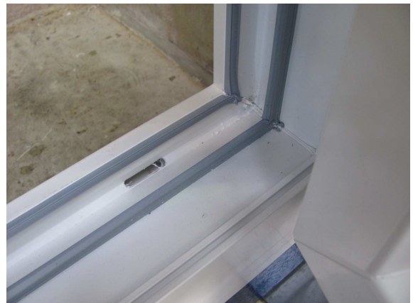
Bild 3 Äußere Anschlagdichtung und Mitteldichtung Blendrahmen, Eckausbildung und Falzentwässerung
