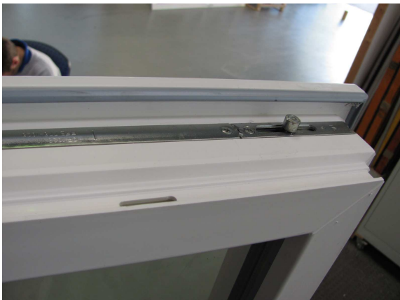
Bild 8 Dampfdruckausgleich Gangflügel
