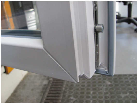
Bild 2 Innere Anschlagdichtung Gangflügel, Eckausbildung
