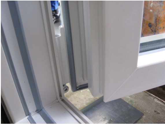
Bild 6 Ecklager Gangflügel
