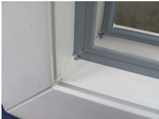
Bild 2 Äußere Anschlagdichtung und Mitteldichtung, Eckausbildung
