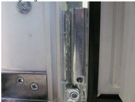
Bild 14 Ecklager, Falzansicht
