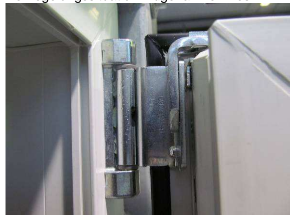
Bild 15 Scherenlager, Falzansicht
