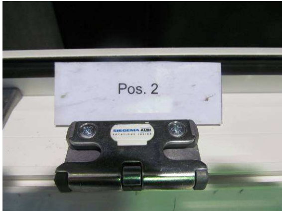
Bild 12 Verriegelungssituation Blendrahmen Pos.2
