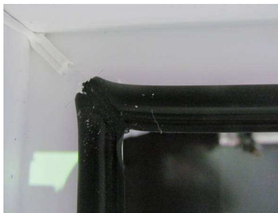
Bild 3 Äußere Anschlagdichtung Flügelbereich, Eckausbildung
