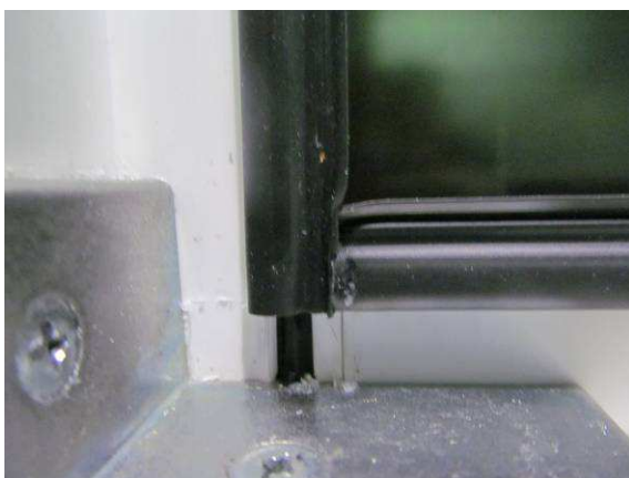
Bild 4 Äußere Anschlagdichtung - Riegelbereich
