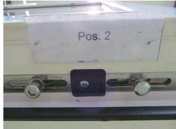
Bild 13 Verriegelungssituation Flügelrahmen Pos.2
