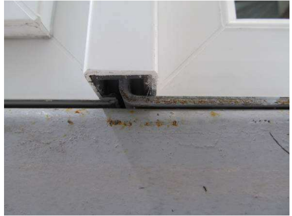
Bild 7 Befestigung Kopplungsprofil unten
