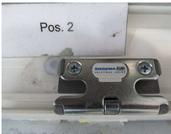
Bild 14 Verriegelungssituation Blendrahmen 2
