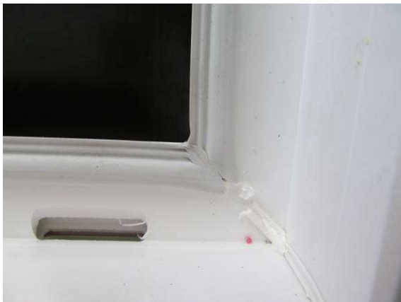
Bild 2 Äußere Anschlagdichtung, Eckausbildung
