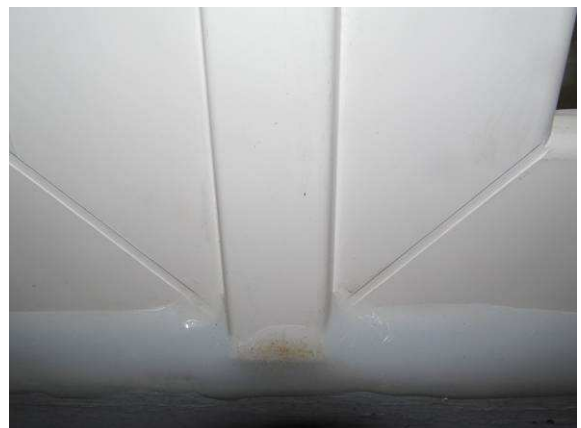
Bild 5 Außenkappe Elementkopplung
