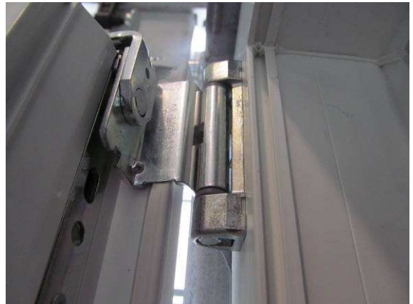
Bild 9 Scherenlager, Falzansicht
