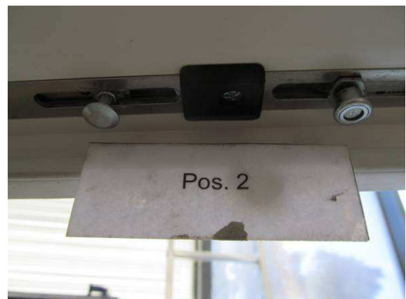
Bild 15 Verriegelungssituation Flügelrahmen 2
