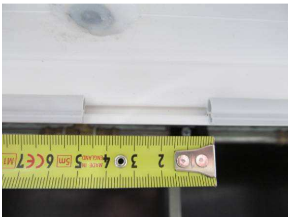
Bild 4 Druckausgleich Blendrahmen
