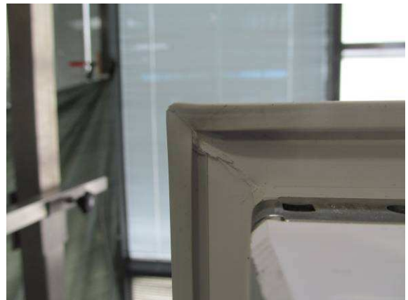
Bild 3 Innere Anschlagdichtung, Eckausbildung
