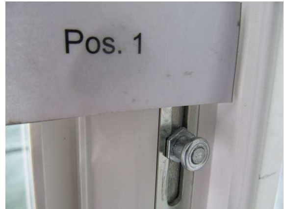
Bild 13 Verriegelungssituation Flügelrahmen 1
