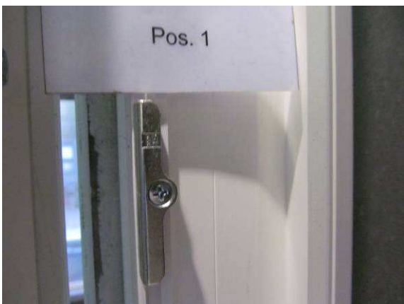
Bild 14 Verriegelungssituation Blendrahmen Pos.1
