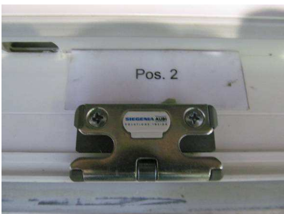
Bild 16 Verriegelungssituation Blendrahmen Pos.2
