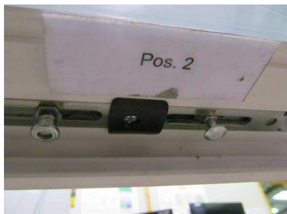
Bild 17 Verriegelungssituation Flügelrahmen Pos.2
