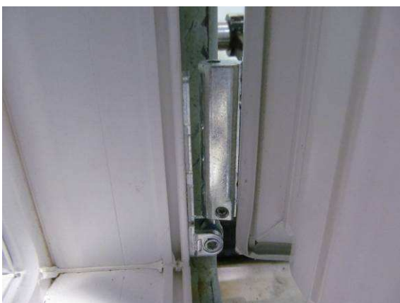
Bild 10 Ecklager, Falzansicht
