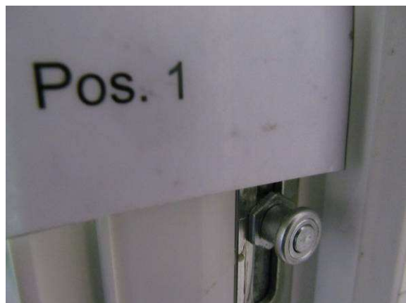
Bild 15 Verriegelungssituation Flügelrahmen Pos.1
