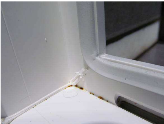
Bild 2 Äußere Anschlagdichtung, Eckausbildung
