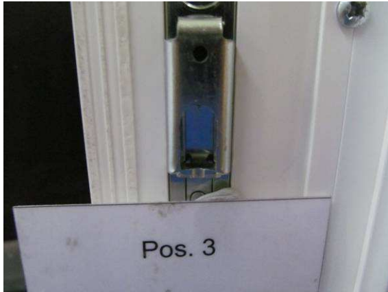
Bild 18 Verriegelungssituation Blendrahmen Pos.3
