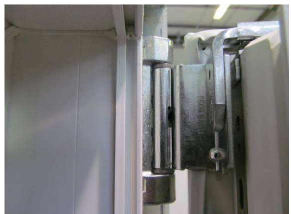
Bild 11 Scherenlager, Falzansicht
