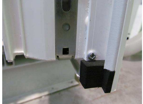
Bild 7 Stulpbereich unten, Gangflügel
