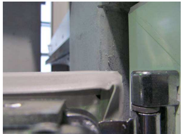
Bild 3 Innere Anschlagdichtung, Eckausbildung
