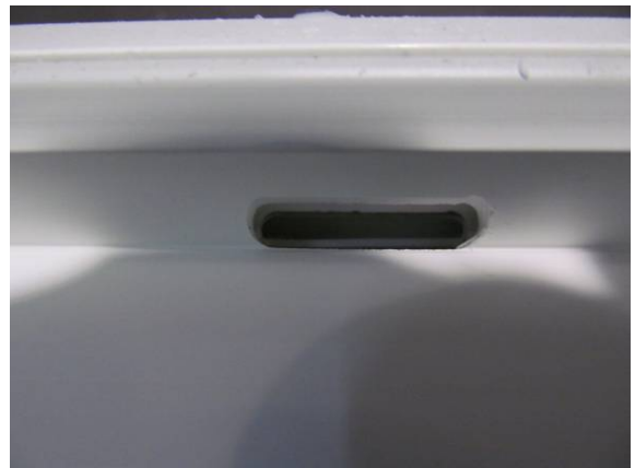
Bild 9 Entwässerung Falz
