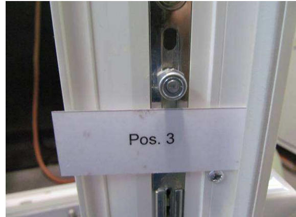
Bild 19 Verriegelungssituation Flügelrahmen Pos.3
