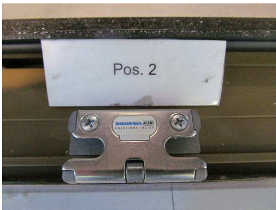
Bild 16 Verriegelungssituation Blendrahmen Pos. 2
