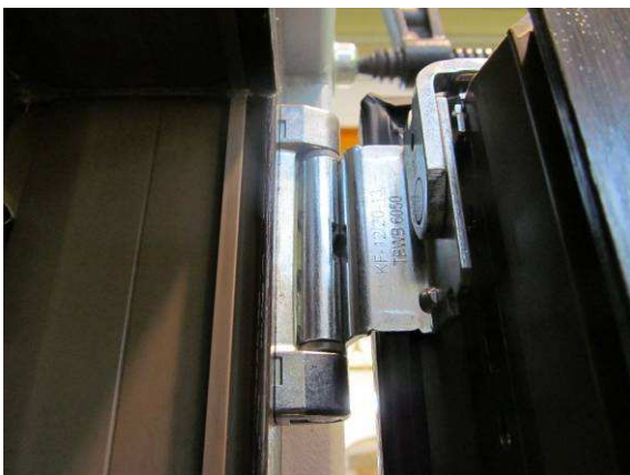
Bild 10 Scherenlager, Falzansicht
