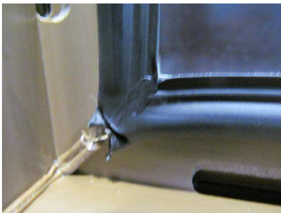
Bild 2 Äußere Anschlagdichtung, Eckausbildung
