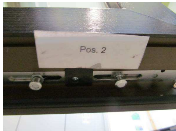
Bild 17 Verriegelungssituation Flügelrahmen Pos. 2
