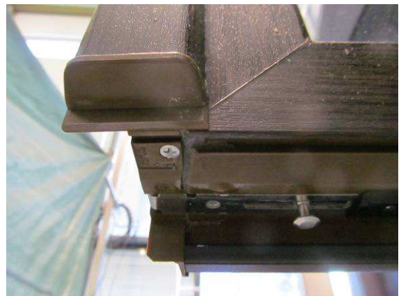
Bild 9 Detail: Innere Anschlagdichtung - Stulpendecke
