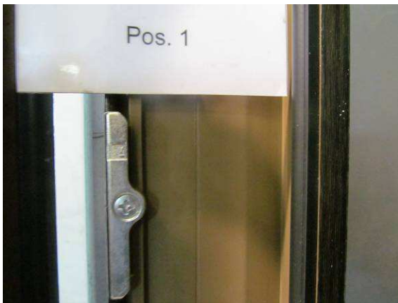
Bild 14 Verriegelungssituation Blendrahmen Pos. 1
