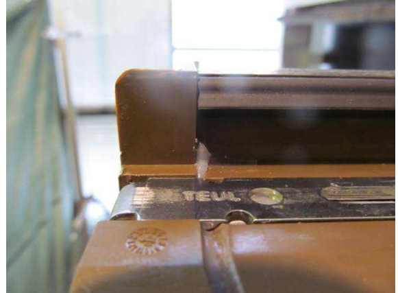
Bild 7 Detail: Äußere Anschlagdichtung - Stulpendecke
