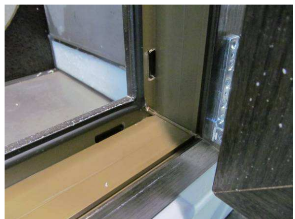
Bild 5 Entwässerung und Belüftung Blendrahmen
