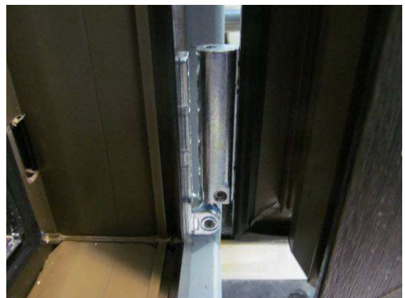
Bild 11 Ecklager, Falzansicht
