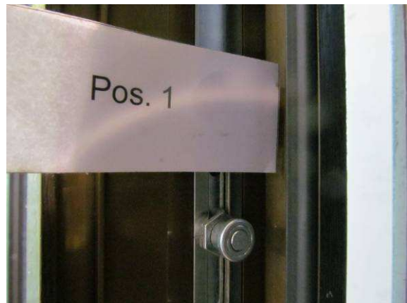
Bild 15 Verriegelungssituation Flügelrahmen Pos. 1
