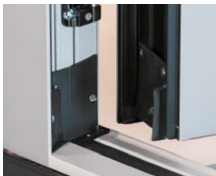
Rubber in de hoek van de deur
